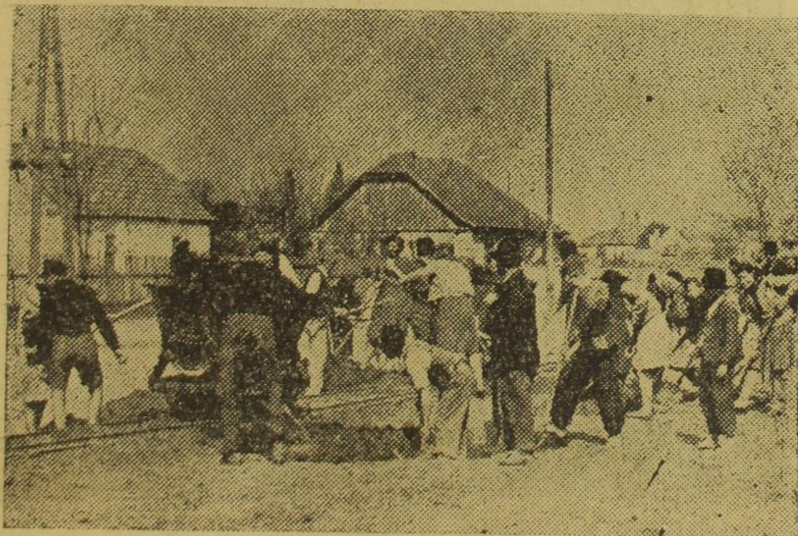
Frontovci rade na podizanju nove pruge koja će povezati tvornicu Zmajevac u Subotici sa teretnom stanicom
