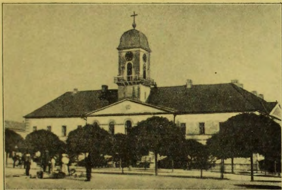
STARA GRADSKA KUĆA GRAĐENA OD 1825—27 PORUŠENA 1908 GOD.
