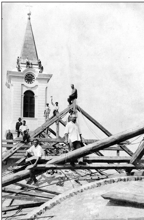
Renoviranje crkvenog krova
