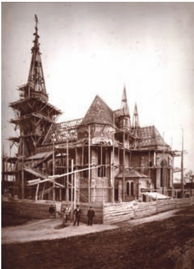
Crkva u drvenim skelama (1895.)
