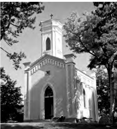
Obnovljena Latinovićeve kapela u Boršotu
