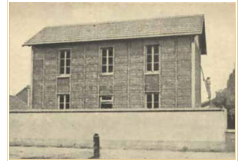
FOTOGRAFIJA KUĆE S VANJSKIM ZIDOVIMA OD BALIRANE SLAME TIJEKOM GRADNJE.
