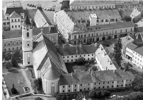
Franjevački samostan i crkva u Baji
