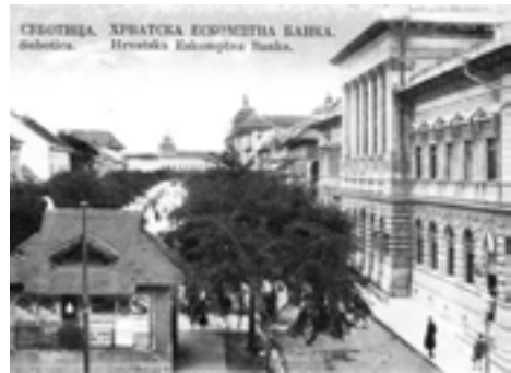
Zgrada Hrvatske eskomptne banke u Subotici
