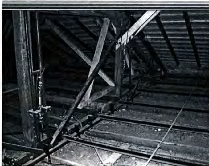
Detalj krovne konstrukcije nakon temeljite obnove
