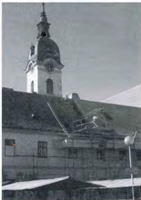
Predstoji obnova vanjskih prozora na kući i žaluzina na tornju
