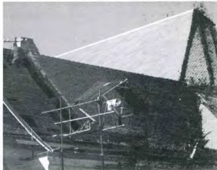
Nastavljeni radovi na zamjeni krovnog pokrivača
