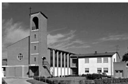
Crkva u Šandoru ( srp. Aleksandrovo) izgrađena po projektu Bolte Dulića
